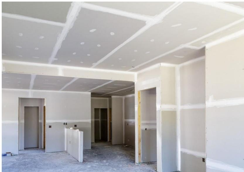
Le pareti perimetrali dell'abitazione saranno contro paretate all'interno in cartongesso con doppia lastra parte interna montata su struttura metallica a telaio. Al loro interno sarà posto isolamento termo acustico in lana di vetro o roccia.
